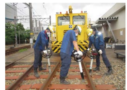
軌道保守(砕石道床つき固め作業)
