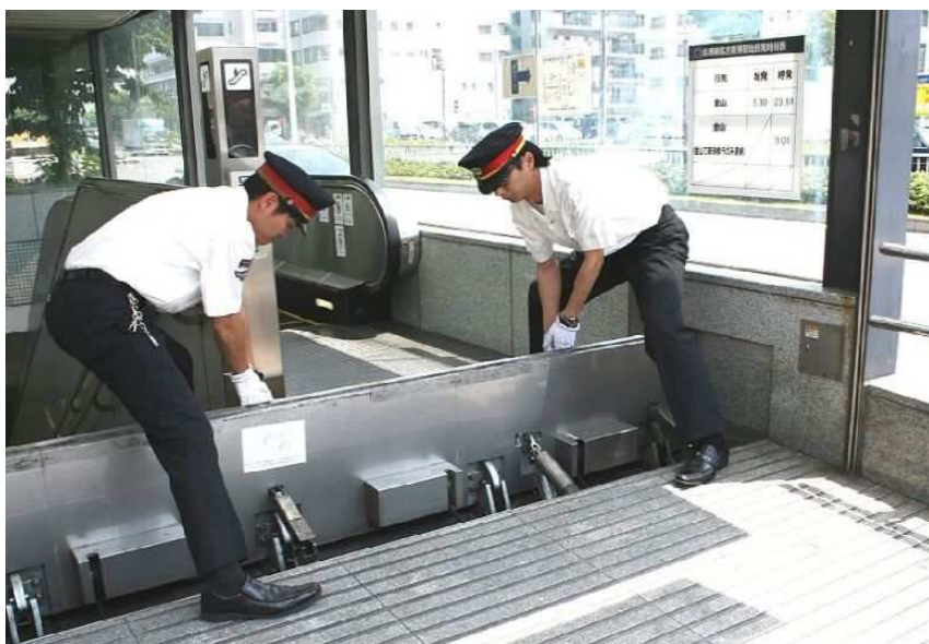
止水板立上げ訓練（名古屋港駅）
