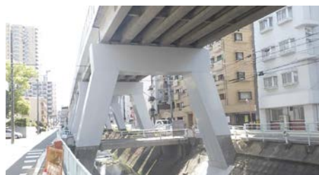
耐震補強を施した橋脚
