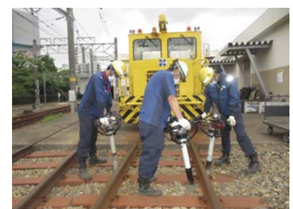
軌道保守（砕石道床つき固め作業）
