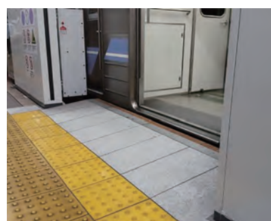
ホームと車両の段差・隙間の解消
