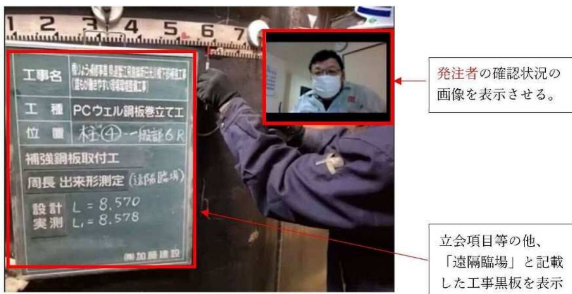
図 2-2-1 立会（遠隔臨場）の記録例
