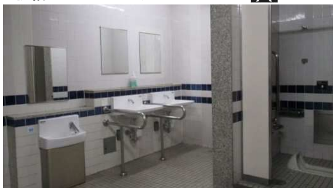
リニューアル前（丸の内駅 トイレ）
