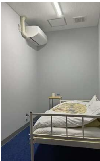
仮眠室個室化（日進工場）
