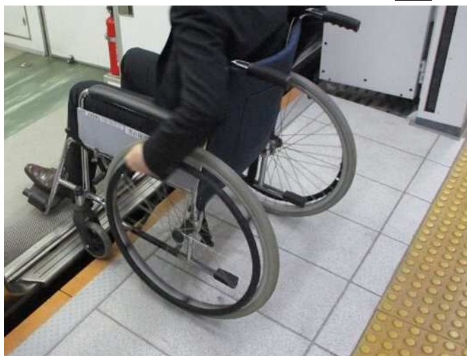
ホーム先端部のかさ上げ
